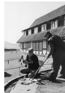
Sanierungsarbeiten auf dem Dach des Seminarraums
